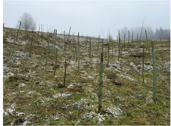
Anlegen einer Gehölzinsel mit dem Zweck, Hangrutschungen zu verhindern und einen Trittstein für Wildtiere zu bilden.
